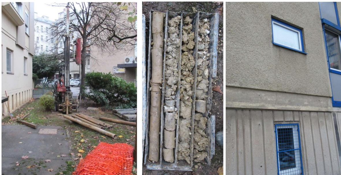
Slike 2.4: Geološko-geomehansko vrtanje (levo), del jedra, odvzetega iz vrtime (sredina) in opažene razpoke (desno).
