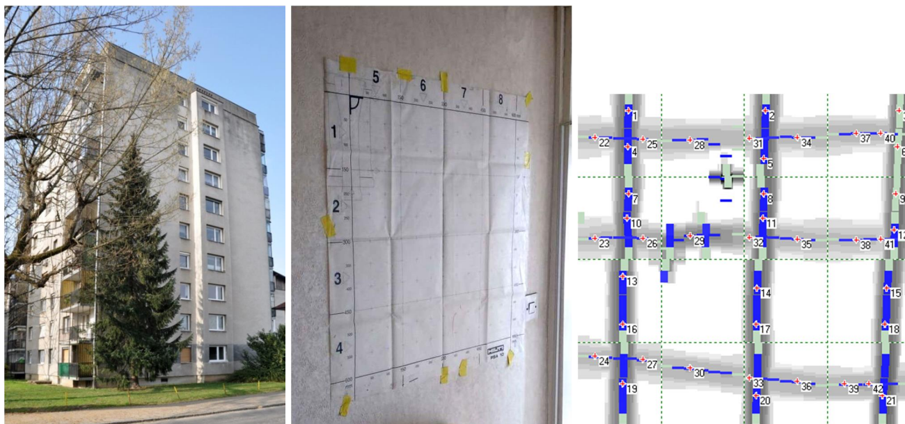
Slike 2.3: Tip C: ena od stolpnic (levo), skeniranje ene od armiranobetonskih sten - pogled in posnetek (sredina in desno).
