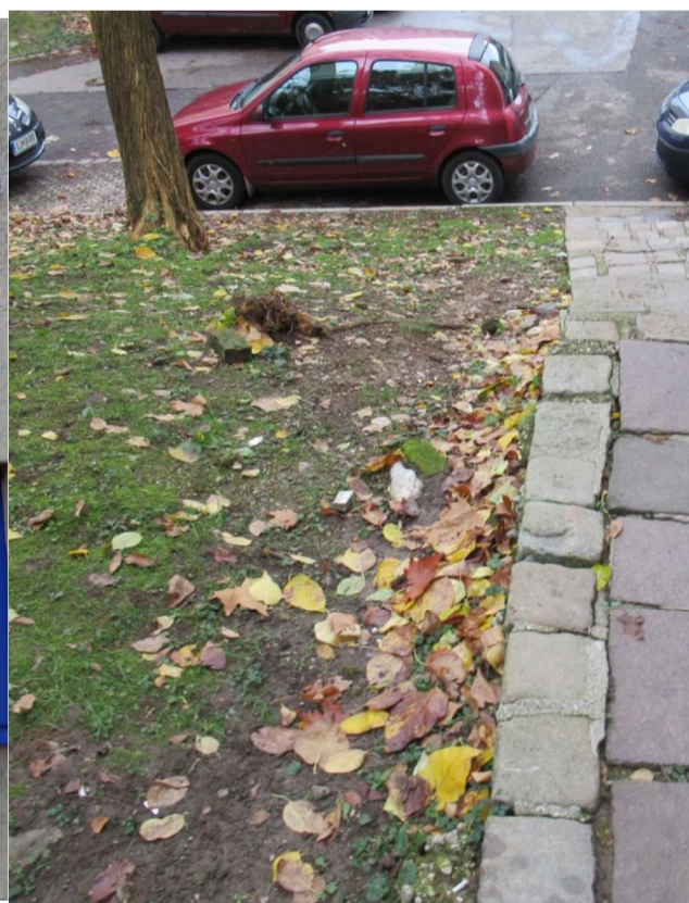
Slika 15: Erozijske poškodbe ob stopnišču, Streliška ulica 1 (Fotoarhiv: 37358d-23)
