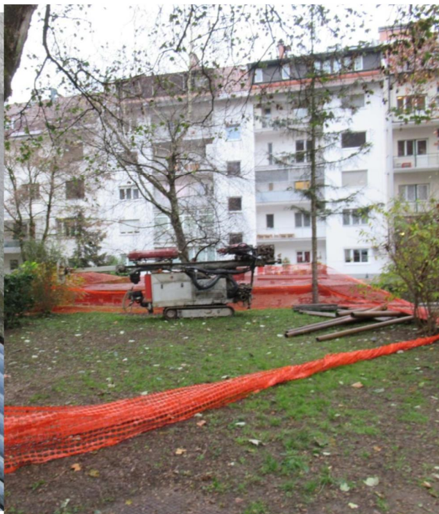
Slika 21: Začetek vrtanja vrtnice VS-5 (Fotoarhiv: 37327d-01)
