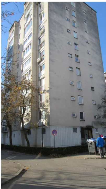
Slika 18: SV fasada stolpnice A1-1 z okolico, 11.12.2018 (fotoarhiv 37494d-183)
