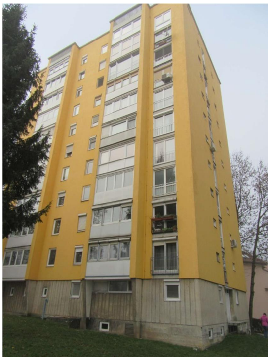
Slika 10: SV fasada stolpnice A1-5 z okolico, 11.12.2018 (fotoarhiv 37494d-010)
